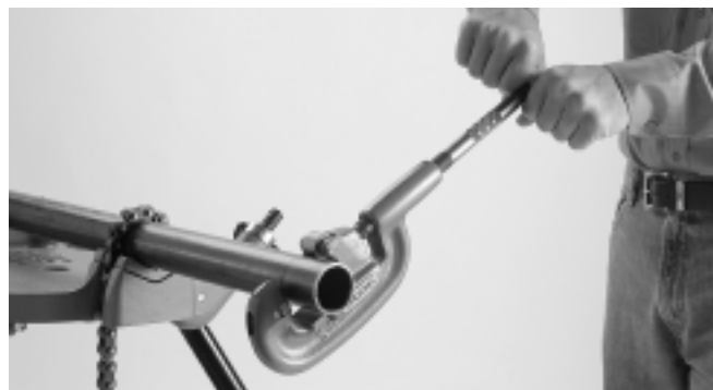
Figura 1 – Corte del extremo del tubo
